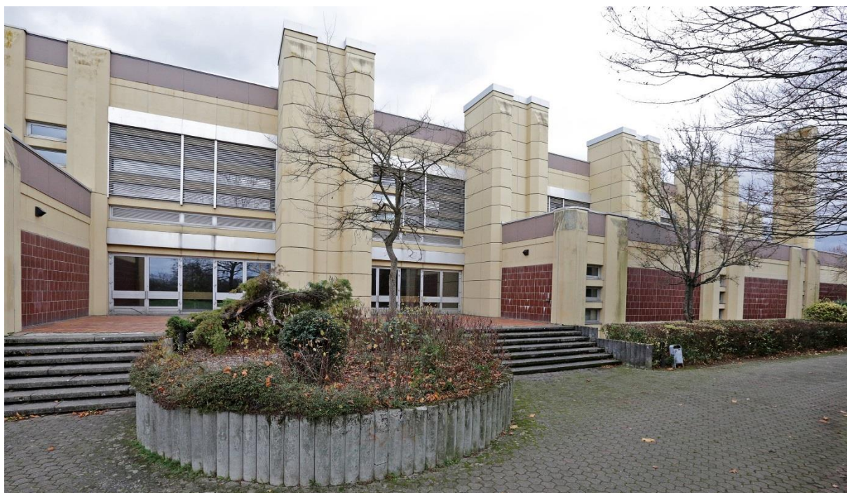
Abbildung 27: hintere Gebäudefassade der 40-Jahre alten Mehrzweckhalle
