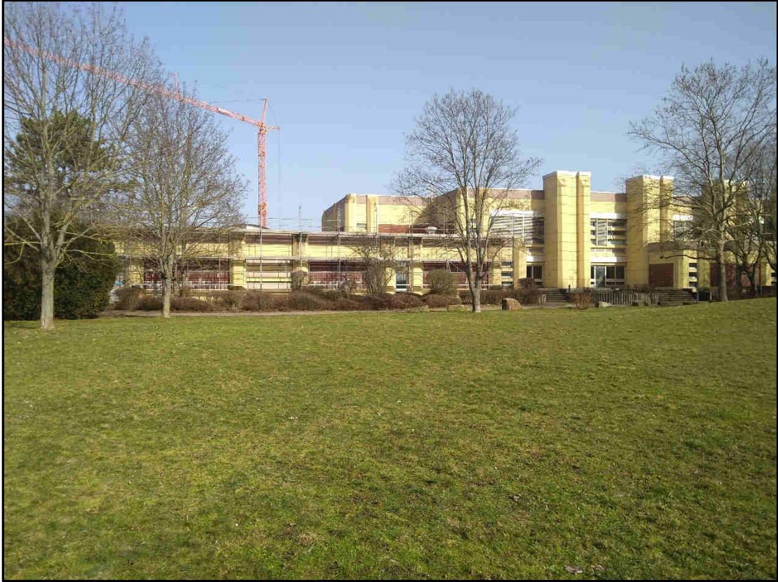
Abb. 5: Blick über einen Teil des Plangebiets Kultur- und Sportquartier Westend auf die Mehrzweckhalle bei Plankstadt von Süden aus.
